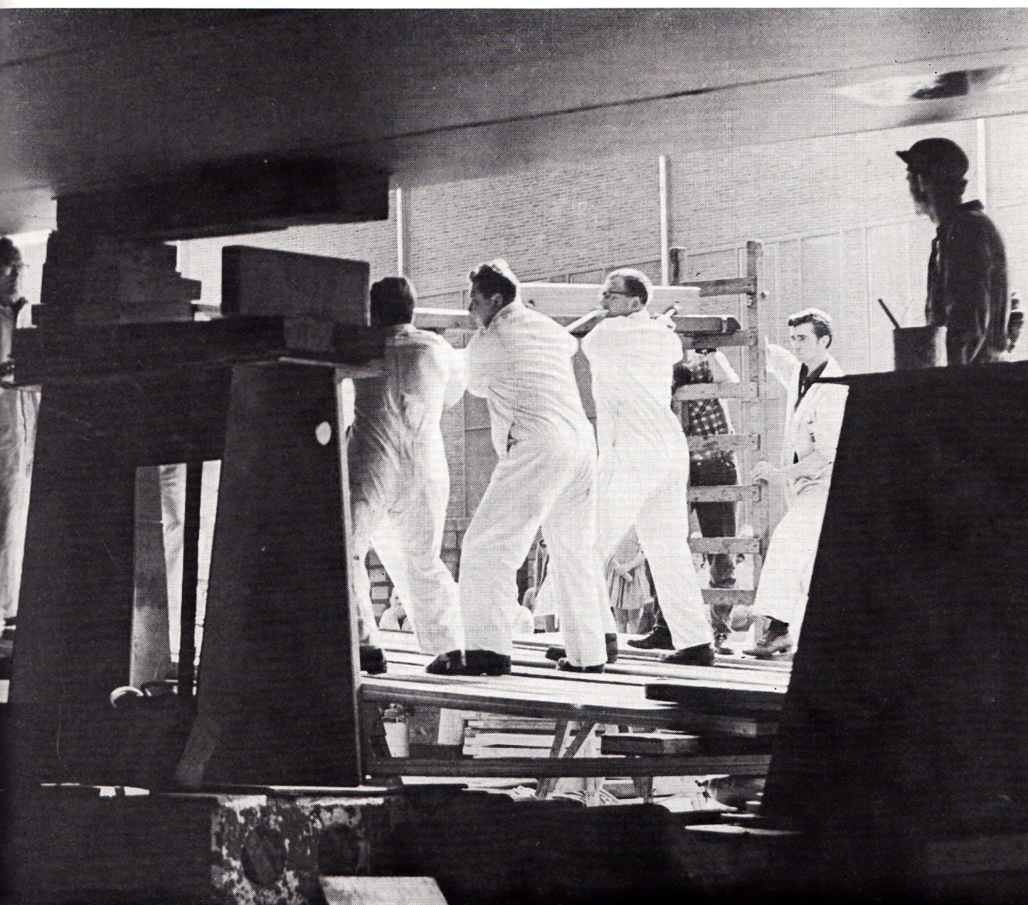
De laatste blokken worden weggeramd. De plaatsen waar ze tegen de scheepswand zaten, worden onmiddellijk daarna geveerd
