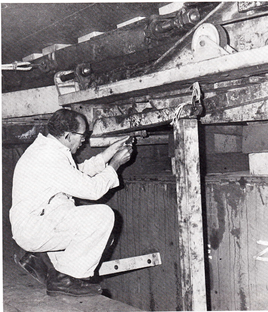
De hangsloten aan de klinken worden verwijderd. Daarna zullen ook de houten stutten weggehaald worden
